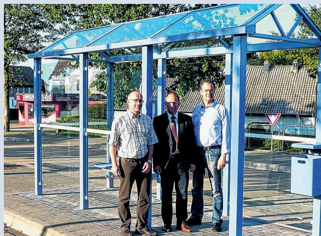
Im zeitlosen Taubenblau präsentieren sich die Metallkonstruktionen der neuen gläsernen Wartehäuschen am Bushof. Die offene gläserne Bauweise verleiht dem Platz ein modernes und freundlicher wirkendes Ambiente.
