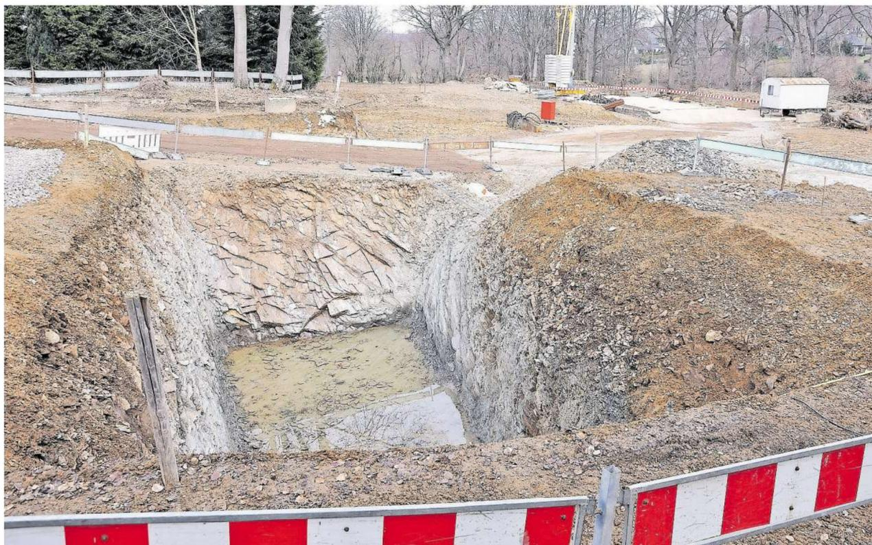
Der weitere Bau des Retentionsbodenfilters am Fischbach in Simmerath ist eine der größten Maßnahmen im neuen Abwasserbeseitigungskonzept der Gemeinde. Die Großbaustelle liegt in Witzerath, nach Fertigstellung soll die Anlage hier ankommendes Oberflächenwasser filtern.
